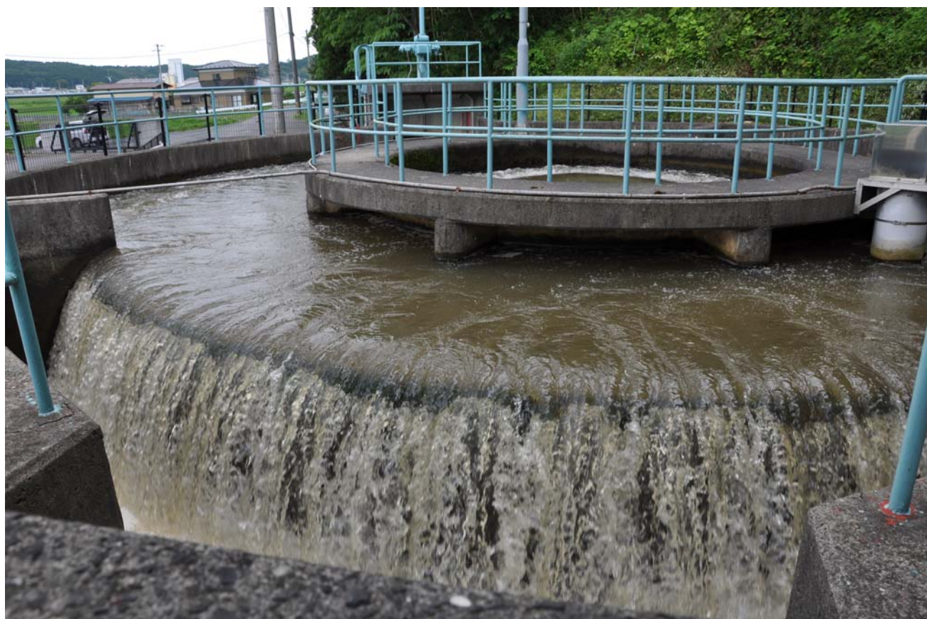
石巻市前谷地円筒三方分水工
