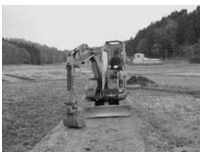
農道の凹凸の整地と敷き砂利
