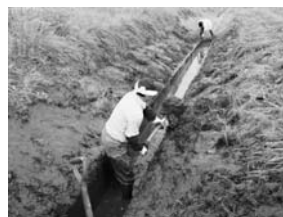
排水路の泥上げ
