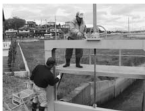
錆止め塗装後の中塗り
