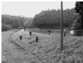
堤防の草刈り（山葵沢ため池）
