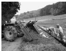
土のうで水路の嵩上げ
