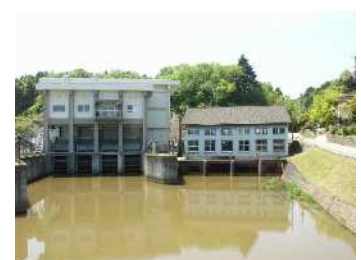
鞍坪排水機場
