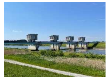
鳴瀬川下流頭首工
