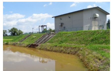
伊豆崎揚排水機場
